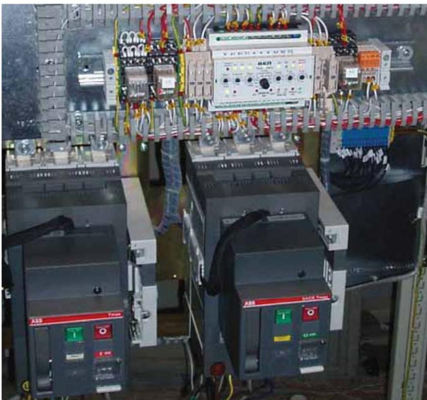
**Пример построения АВР на автоматических выключателях серии Tmax производства АВВ, типоразмеры Т4-Т6 с моторно-пружинным приводом, управлением от БУАВР.С.220, двумя вводами, двумя группами нагрузок, с секционным выключателем, электрической блокировкой автоматических выключателей, защитой от переключения между вводами при перегрузке или коротком замыкании в нагрузке, возможностью управления АВР в автоматическом и ручном режиме.**
